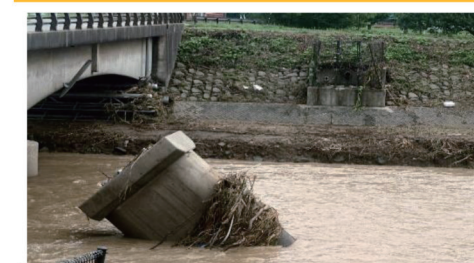
7/27 荒瀬川にかかる桜橋。桜橋の横にあった水道橋が流されてしまいました。橋の上に応急管を敷設仮復旧。
