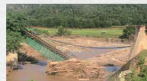
2022年8月豪雨 米坂線の鉄橋崩落(飯豊町)
