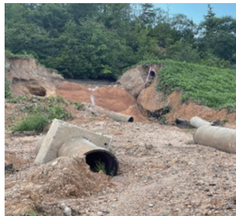
川西町 農業用水の導管が破断・崩落
